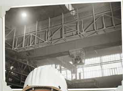
Kran im Stahlwerk Salzgitter
